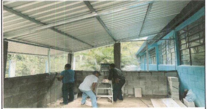
Foto1: Mejoramiento de cocina, estructura y techado de lamina troquelada calibre 26
