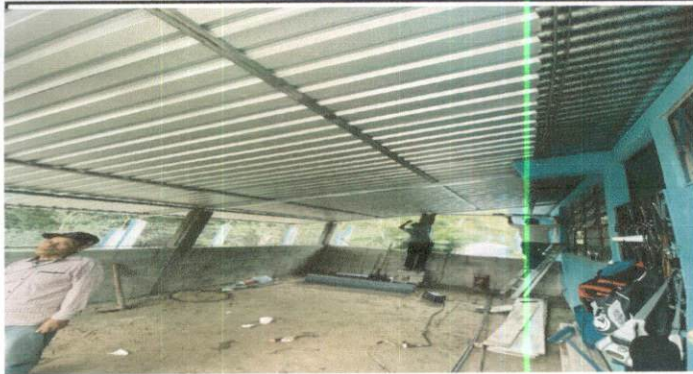
Foto1: Mejoramiento de cocina, estructura y techado de lamina troquelada calibre 26
