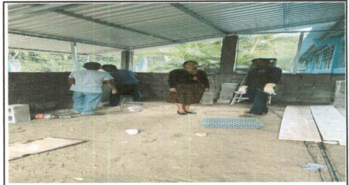
Foto 2: Mejoramiento de piso de cocina
